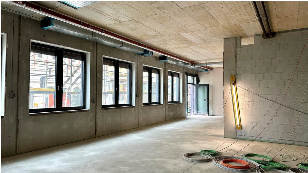
Der künftige Eingangsbereich von „Action“, zugänglich von der Straße Neumarkt in Schwelm. Hier wird noch eine Schiebetür eingebaut.
