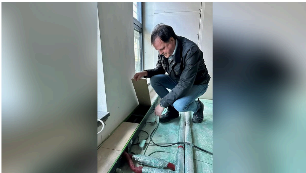
Thomas Striebeck, Chef des Technischen Immobilienmanagements der Stadt Schwelm, zeigt, wo die Heizungsanlage in den Büros installiert wird.
