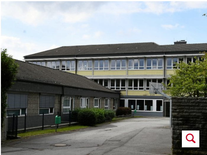
Die Dietrich-Bonhoeffer-Realschule leidet an akuter Raumnot. Die Verwaltung favorisiert den Ausbau des Dachgeschosses. Foto: Bernd Richter / WP
