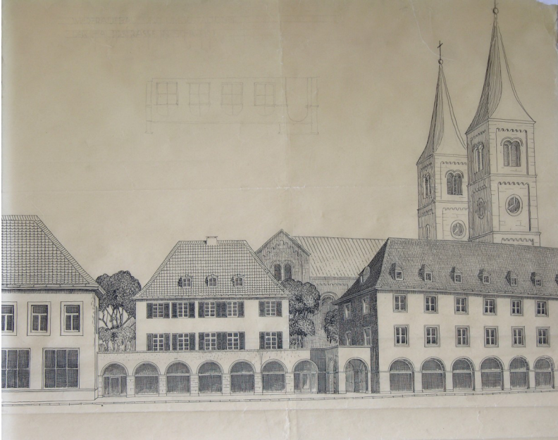
Abb.3.6: Umgestaltung der Hauptstraße, A. Lutter, 1947
