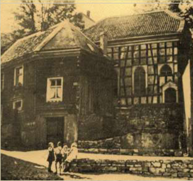
Die alte Schwelmer Synagoge
