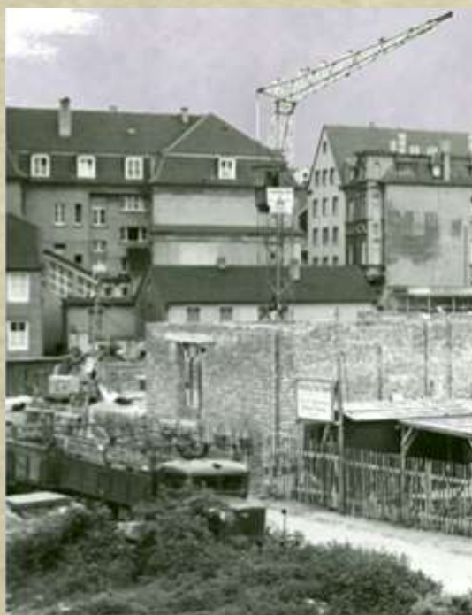
(links) Wiederaufbau an der Bahnhof- und Untermauerstra enecke. (rechts) Wiederaufbau des Turms der Marienkirche 1955
