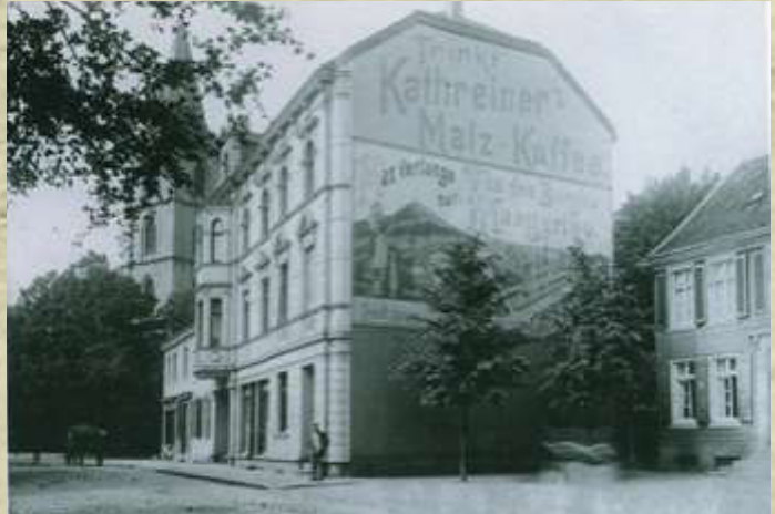
Bahnofstraße unterhalb der Kirche: Wo heute die Einmündung zur Haynauerstr ist, stand bis 1945 ein Fachwerkhaus (rechts)
