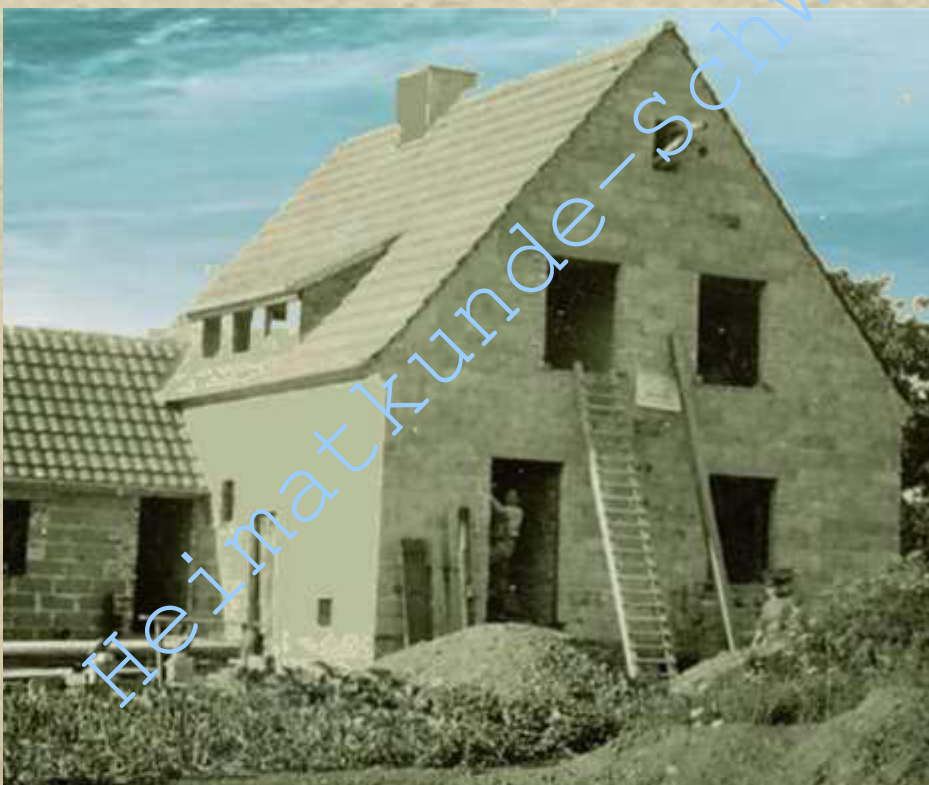
(rechts) Trümmerbeseitigung Bahnhofstr.- Hauptstr Ecke (links) Grundsteinlegung bei der Siedlergemeinschaft „Neue Heimat“. Hier beim Haus Geilen (unten)
