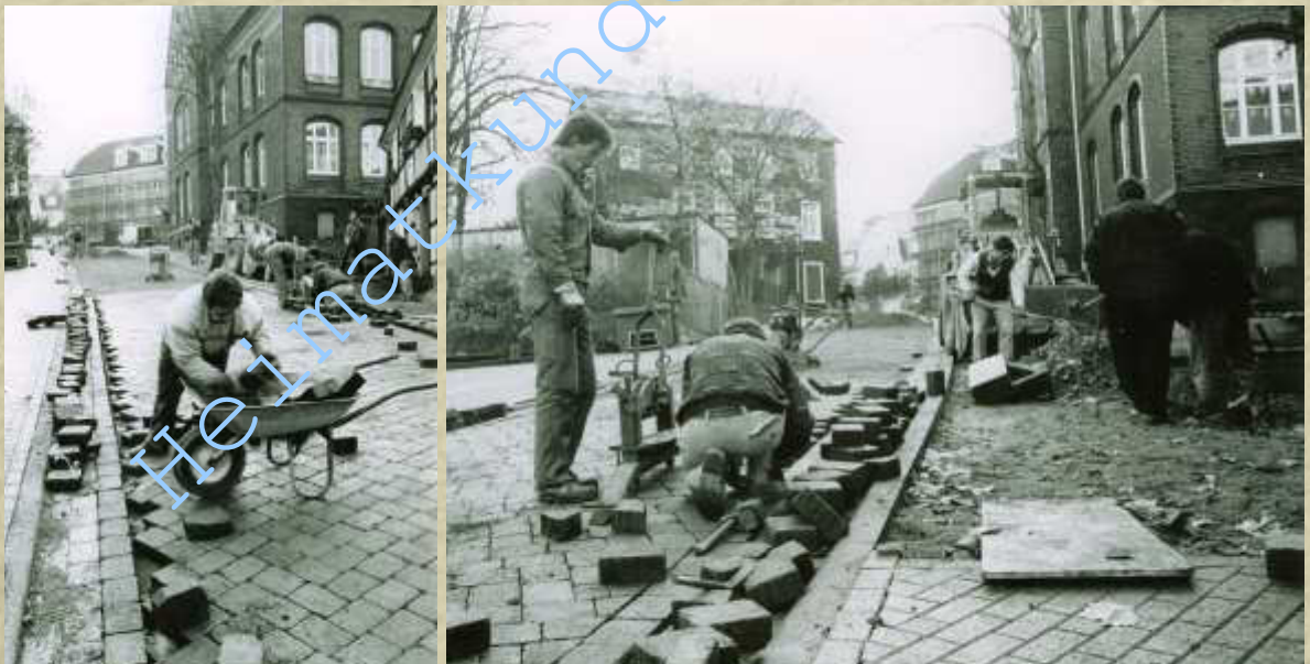
Die Fußgängerzone lädt zum Verweilen ein (oben) Die Südstraße zur Zeit der Neugestaltung (unten und links)
