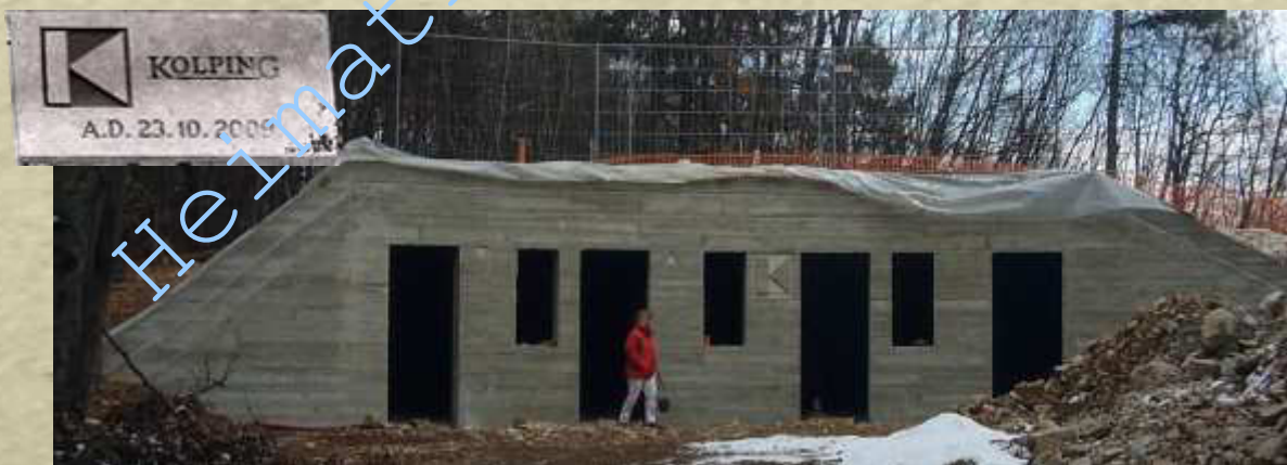
Ab 2009 rollten die Bagger zum Bau eines modernen Küchen- Lager- und Toilettenhauses auf dem Zeltplatz in Graun an. Oben links die Grundsteinplatte, datiert vom 23.10.2009
