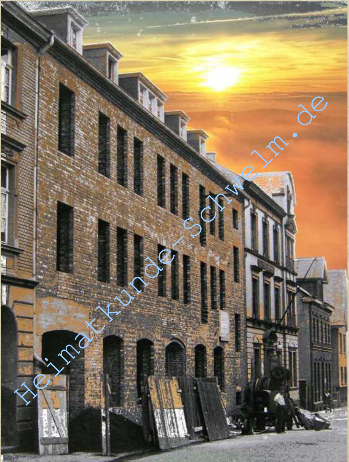
Das Jugendwohnheim im Rohbau Spätsommer 1951
