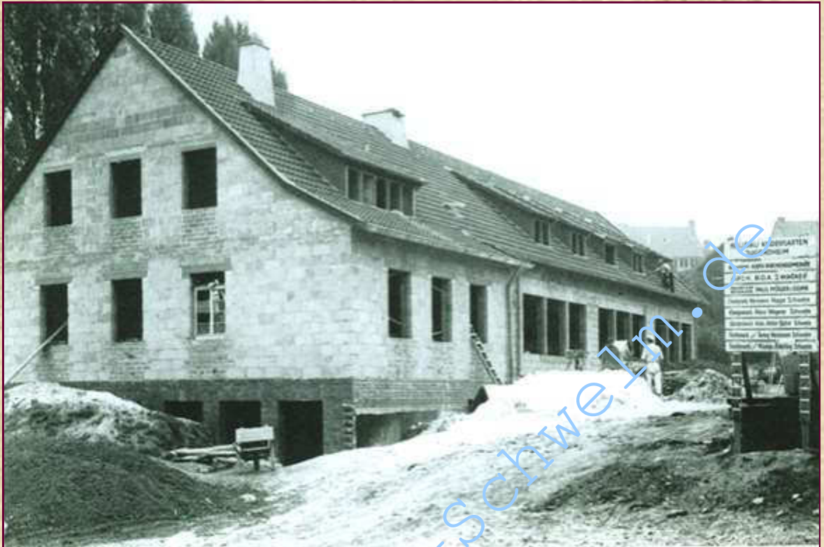
Kindergarten und Jugendheim am Marienweg - Rohbau März 1955
