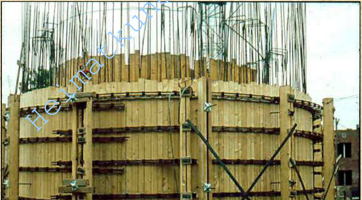
Links: Grundplattenschalung des Turmes - rechts: Wandschalung des Turmes (1968 / 1969)
