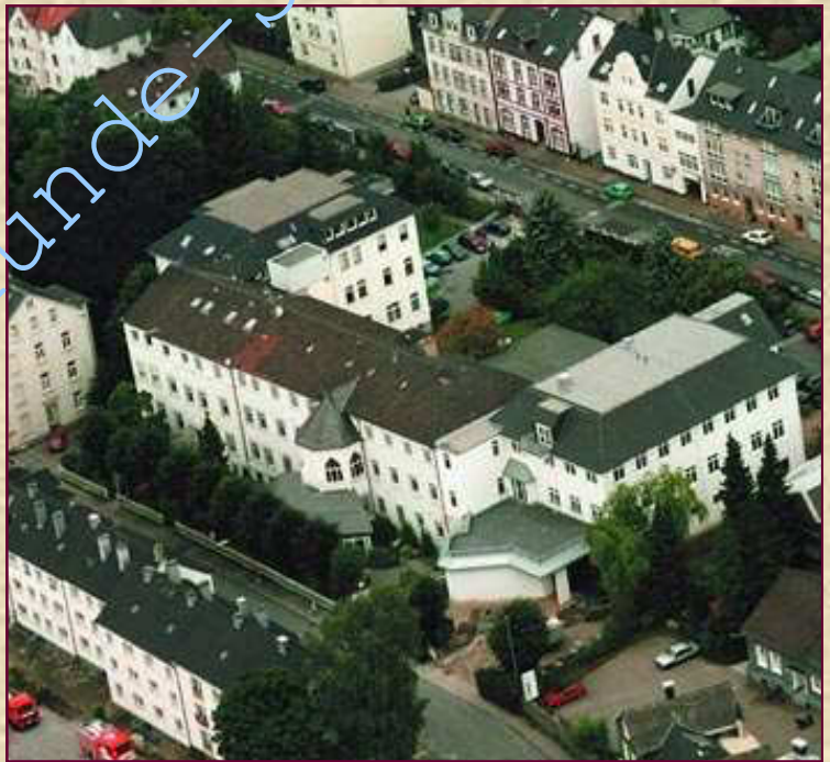
Das Marienhospital nach dem Erweiterungsumbau
