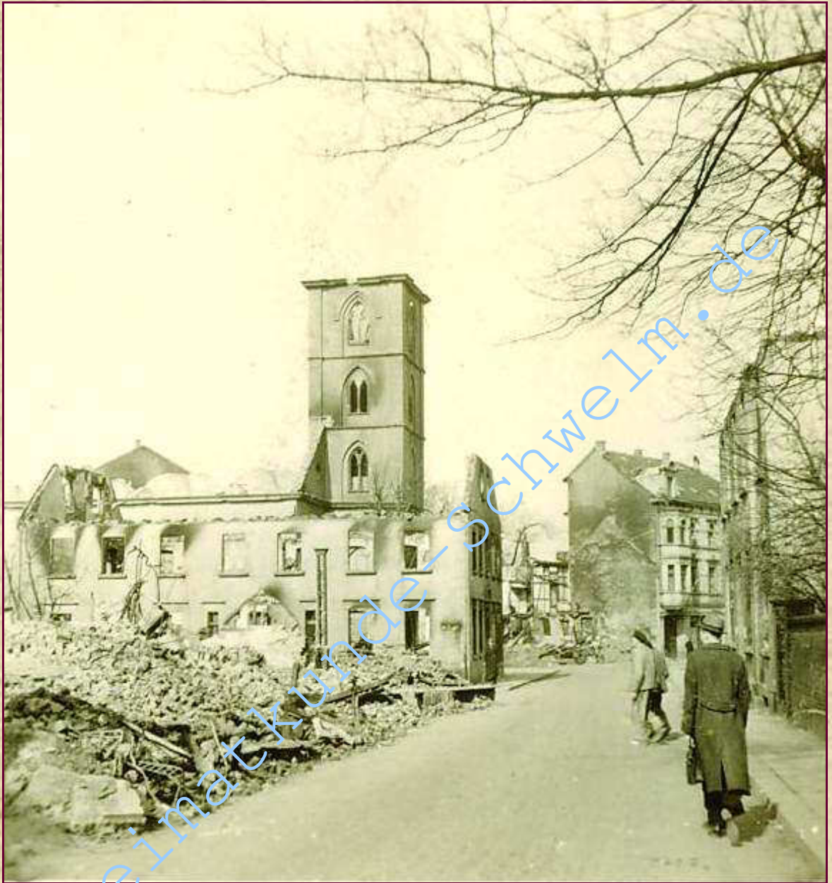
Am 3. 3. 1945 von Bomben zerstört: die Kirche , das Pastorat, alle Häuser in der oberen Bahnhofstraße
