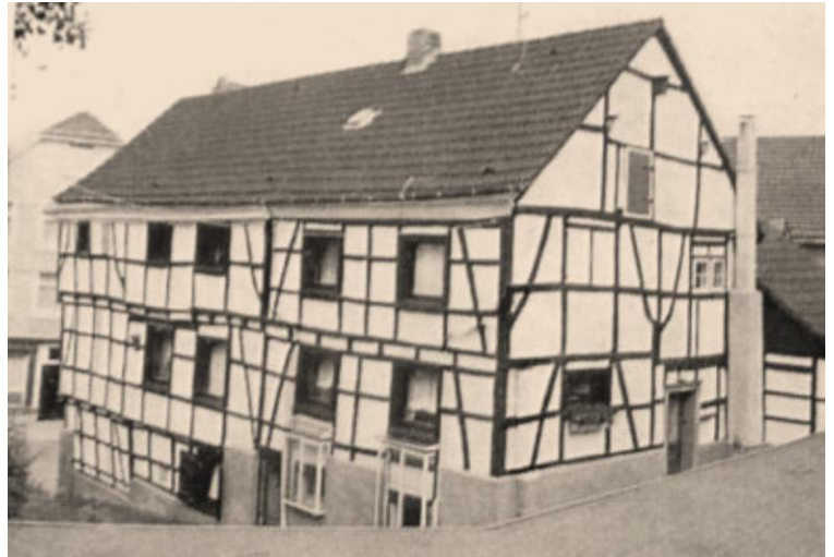
Bild 35 Haus 25 (83) Fuselbrenner Johann Gottfried Kreft
