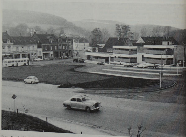
Der Busbahnhof in Winz — Ortsteil Nierenhof — wurde zur Entlastung des Durchgangsverkehrs an der Kreuzung Essen—Langenberg—Hattingen 1964 von der Gemeinde gebau-
