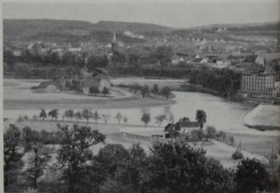
Gesamtansicht mit neuem Ruhrbett und Wehr, im Vordergrund Campingplatz Stolle
