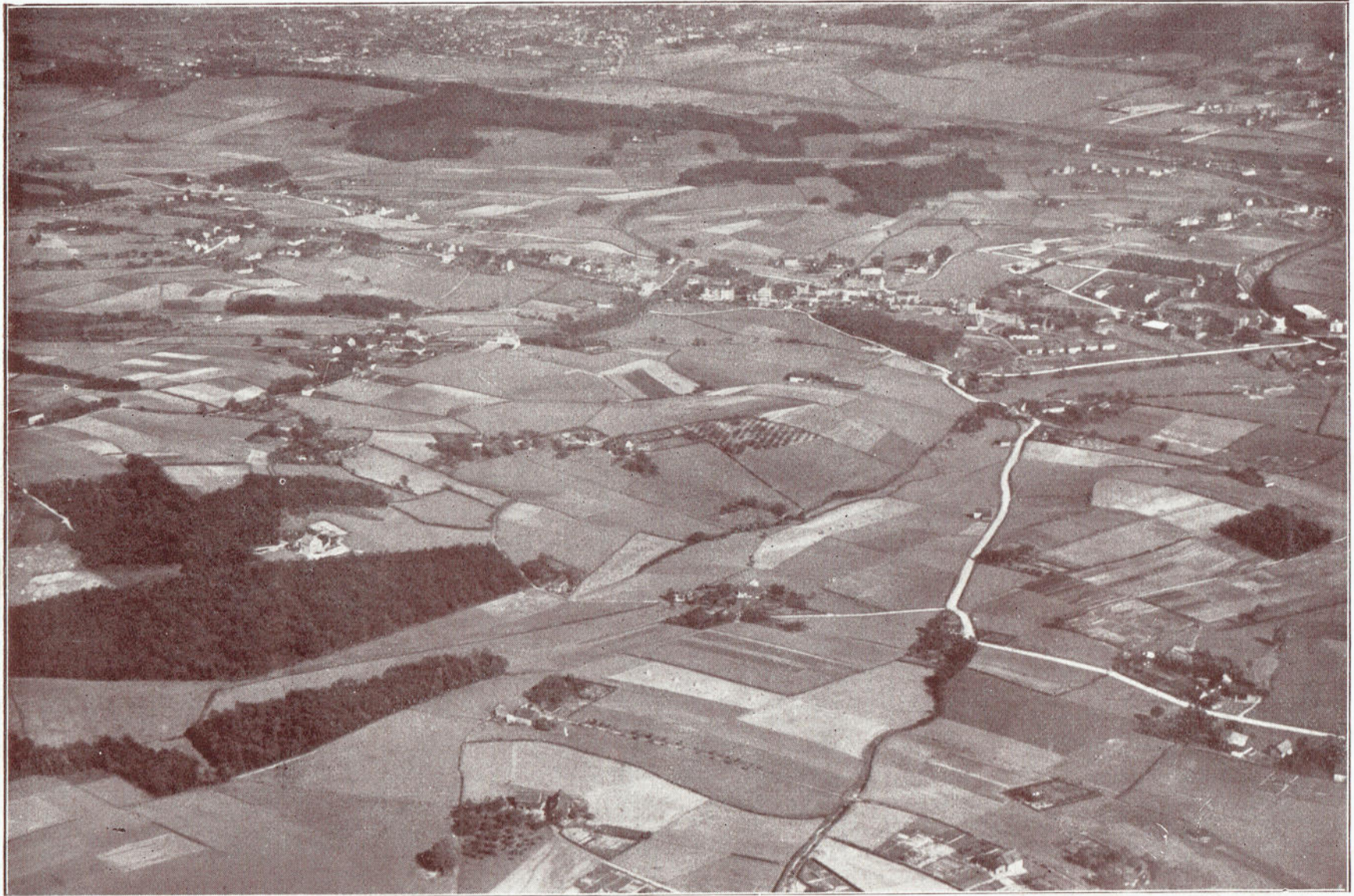
Barmen-Nöstebeck, im Hintergrund die Stadt Schwelm und die Straße nach Barmen-Langerfeld.
