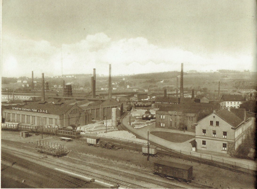
Teilansicht von Werk I. Im Vordergrund die Reichsbahnstrecke Köln—Berlin, dahinter rechts das Geschäftsgebäude, links anschließend Stapel eiserner Fässer, fertig zum Abtransport, weiter links die Faßfabrik (Schweißerei).
