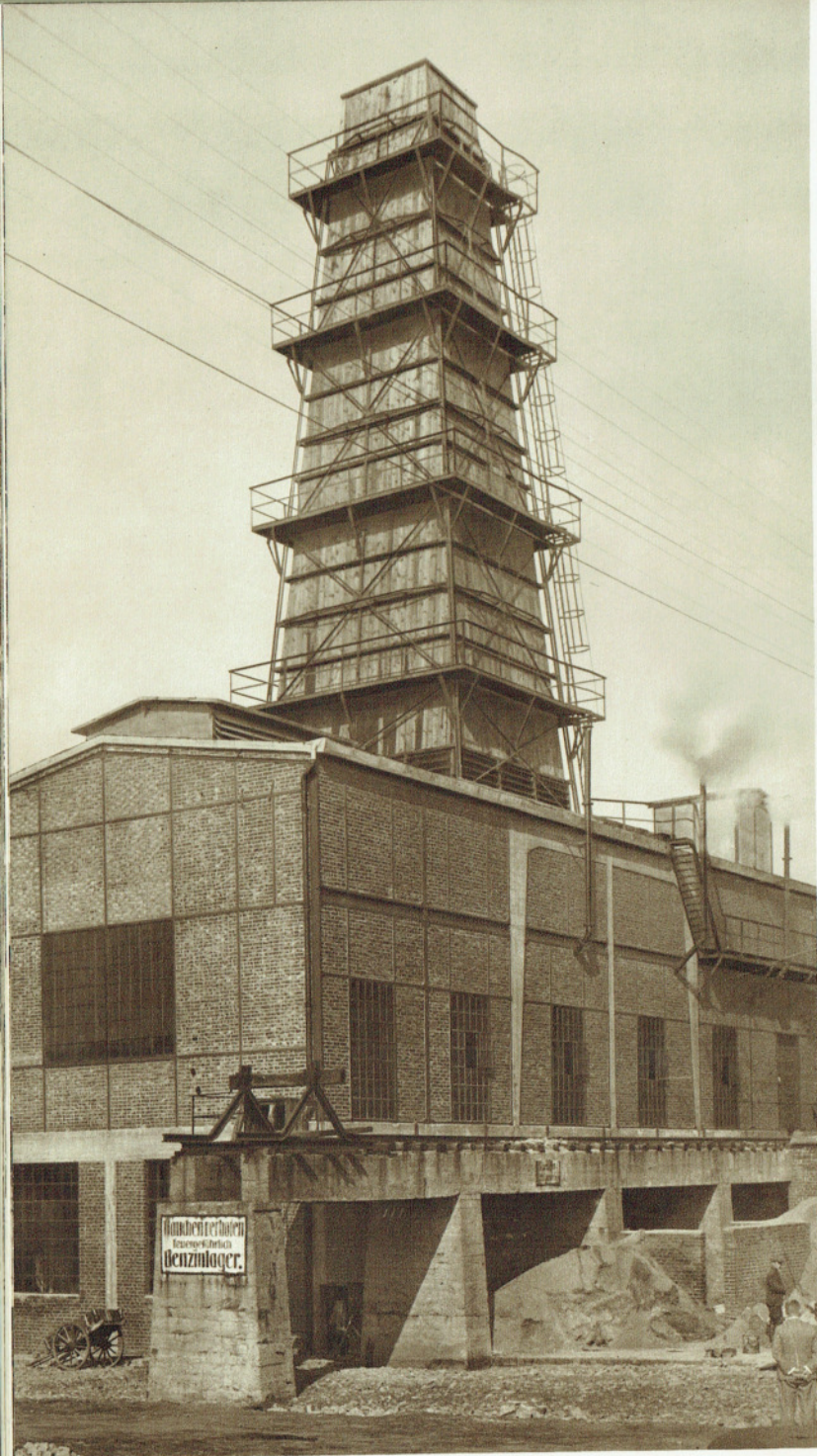
Generatorenhaus mit Kühlturm im Werk I.
