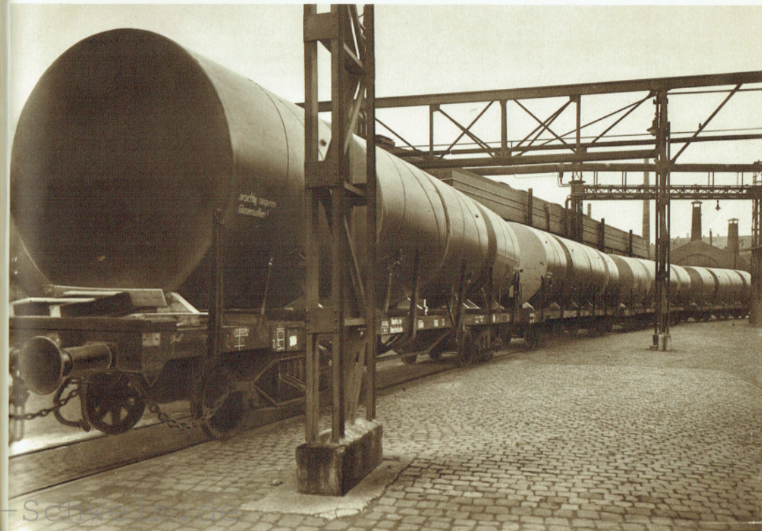
Ein Eisenbahnzug mit innen glasemallierten Tanks.
