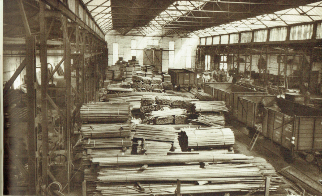
Inneres der Vorrichterei, in der die Rohmaterialien für die Faßfabrikation vorgerichtet werden.
