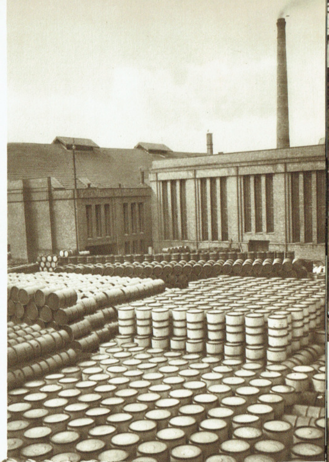
Stapel von Fässern verschiedener Konstruktionen, die auf den Abtransport warten. Gleisanlagen durchziehen das ganze Werk, um die Verladung überall bequem vornehmen zu können.
