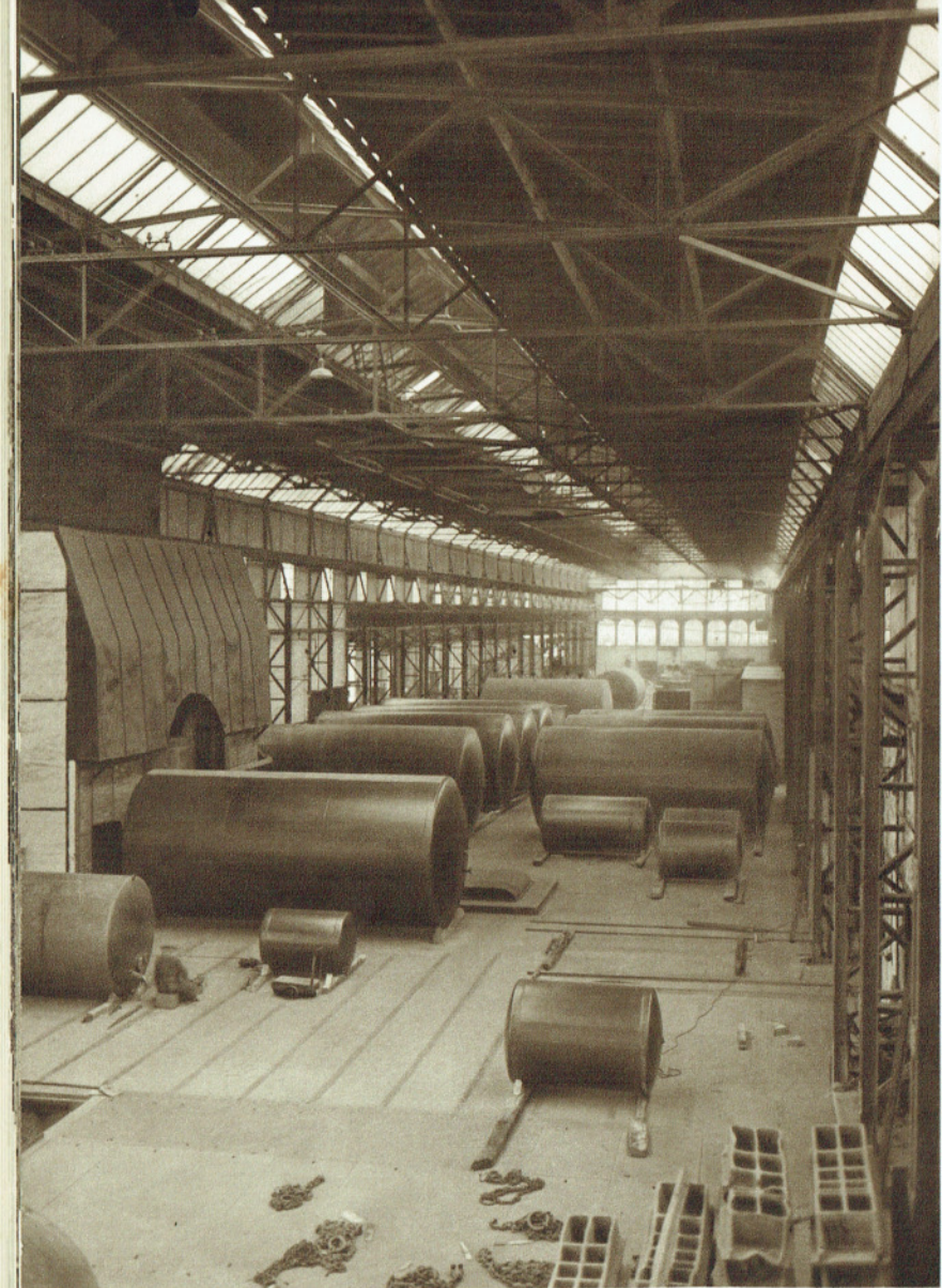
Blick in das Innere des Bottichwerks, in dem die Tanks von 500 bis 100 000 Liter Inhalt zu einem Stück zusammengeschweißt werden.
